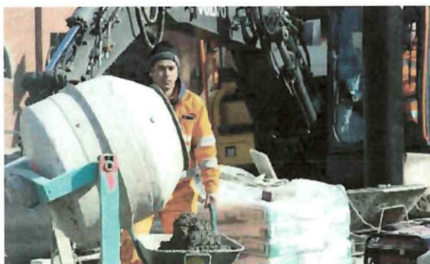
Partenza quasi in contemporanea per gli interventi su due importanti strade di collegamento (nell'immagine una foto d'archivio)
